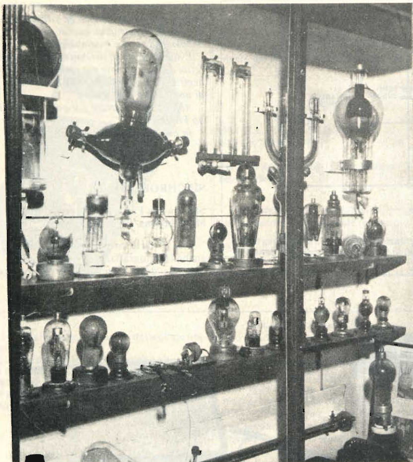
Fig. 9 - Una ricca collezione di tubi elettronici a gas (rettificatori, thyatron ecc.). Alcuni esemplari sono rarissimi, pressochè unici.
